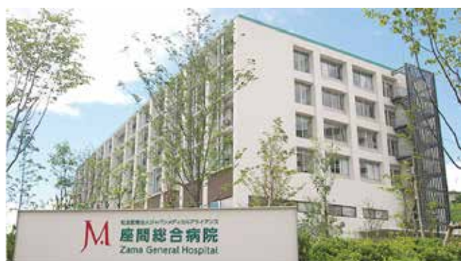
写真1 座間総合病院 外観
